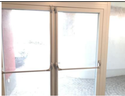
Uscita di emergenza lato Ovest – Via San Antonio
