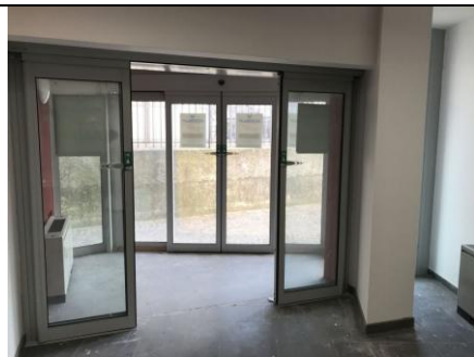
Uscita di emergenza ingresso lato Est – Piazza Libertà
