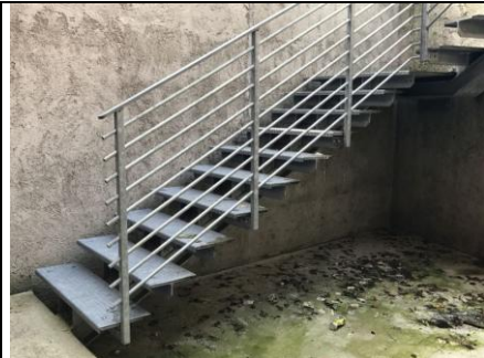
Scala accesso al giardino interno
