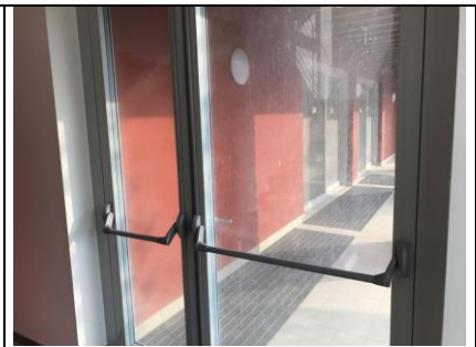
Uscita di emergenza verso giardino lato Ovest
